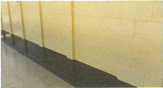
Foto 2: Colocación de pintura corona clásica color blanco antiguo y rojo teja, en aulas existentes.
